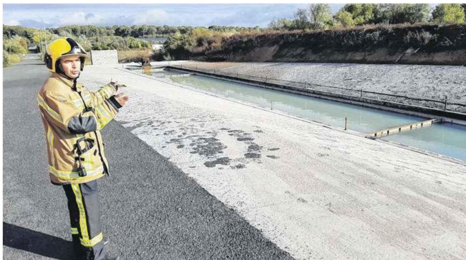
Sur cette cuvette de 300 m 2 , le Gesip étudie la propagation d'un feu face à la mousse d'extinction des incendies, utilisée également par les pompiers.
