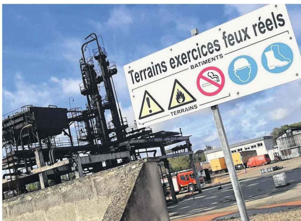
Le site du CNPP était autrefois une raffinerie. Ces installations ont été conservées pour les formations.
